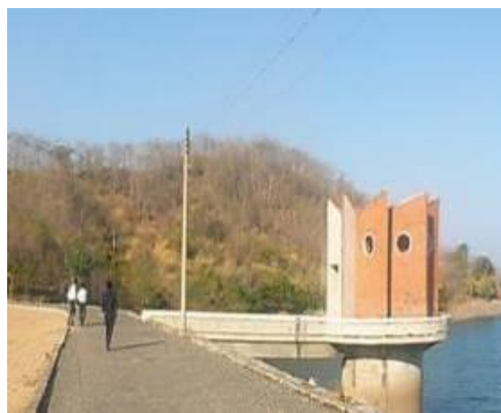
Khảo sát hiện trạng TDA hồ Sông Quao
