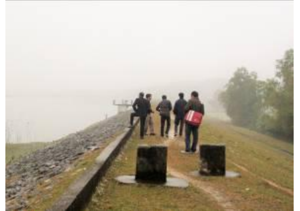
Khảo sát hiện trạng TDA hồ Đồng Bể
